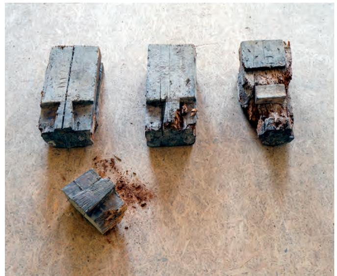
Schwalbenschwanzverbindungen an schadhaften Balkenköpfen, die an der Ostseite der Decke über dem Erdgeschoss entnommen wurden. Sie deuten auf die handwerklichen Fertigkeiten der der Zimmerleute hin, die das Haus 1783–85 bauten.
