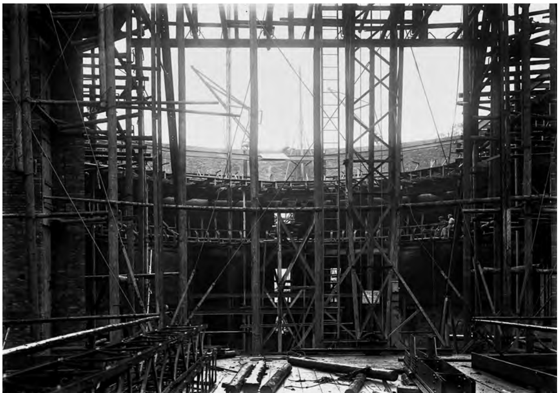
Die Baustelle des Großen Hauses um 1910. Blick von der Bühne in den zukünftigen Zuschauerraum mit seiner bereits aufgemauerten Umfassungswand
